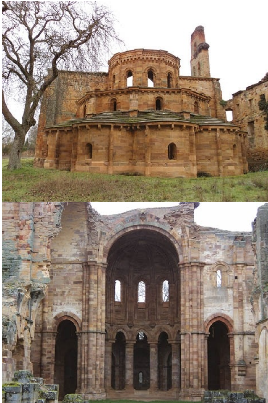
Exterior e interior de la compleja y semiderruida cabecera del monasterio cisterciense de Moreruela de Tábara (Zamora), rodeada por girola abierta a siete capillas radiales semicirculares cubiertas con bóveda de horno. Fotos del autor.
