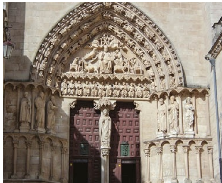
Portada del Sarmetal en la catedral burgalesa. Preside el parteluz la estatua de un obispo, probablemente san Mauricio, iniciador de las obras del templo. En el tímpano, Cristo juez flanqueado por el tetramorfos. Foto del autor.
