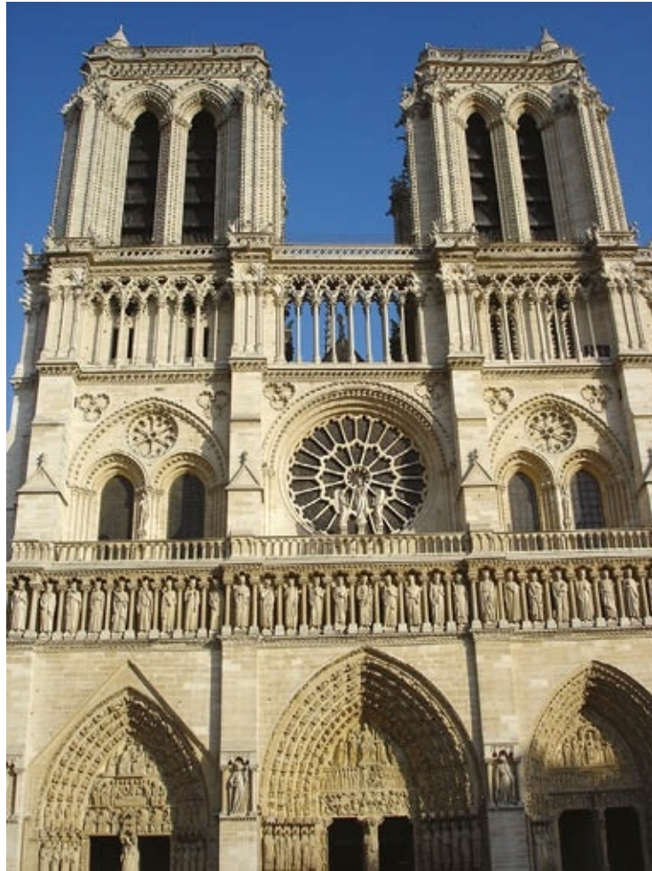
Fachada principal de Notre-Dame de París. Flanqueada por dos torres cuadradas, presenta triple pórtico rematado por figuras en friso sobre el que se abre un rosetón entre dos grandes ventanales; encima corre una arquería. Foto de Alfredo Galindo.
