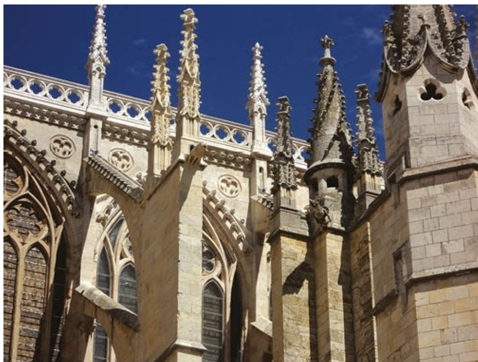
En la catedral de León, los dobles arbotantes transmiten los empujes laterales de la nave mayor a los contrafuertes, coronados por bellos pináculos que los adornan y apuntalan con su peso, además de acentuar la sensación de verticalidad, características todas del arte gótico. Foto del autor.
