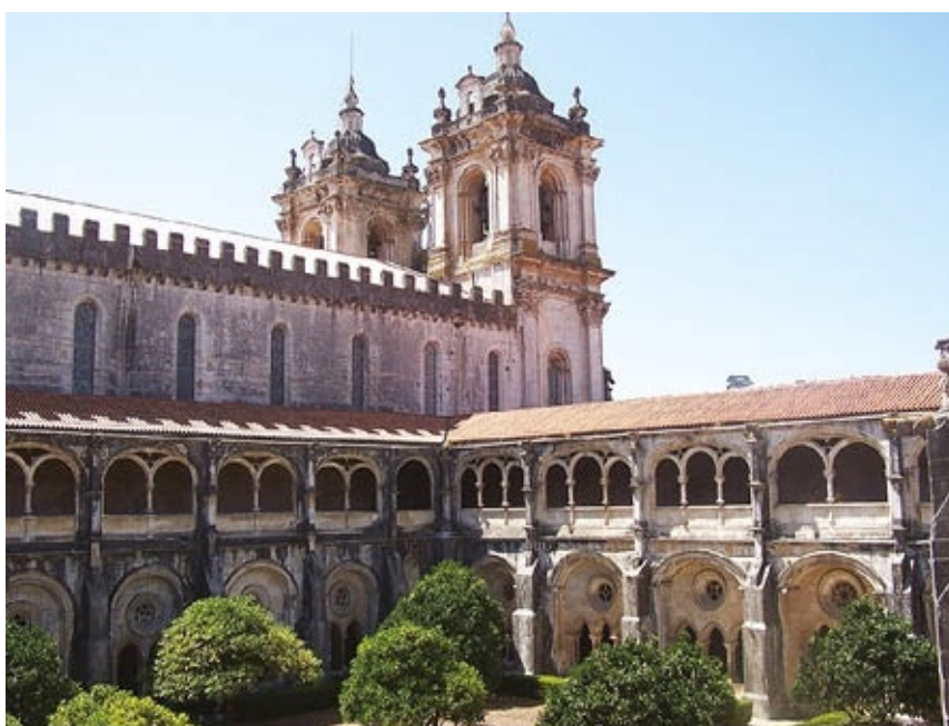
Claustro del monasterio cisterciense de Santa María de Alcobaça (Portugal), edificado en el siglo XIV. En su entorno se disponen la sala capitular, la cocina, el lavabo y el refectorio. Las torres, al fondo, son barrocas.
