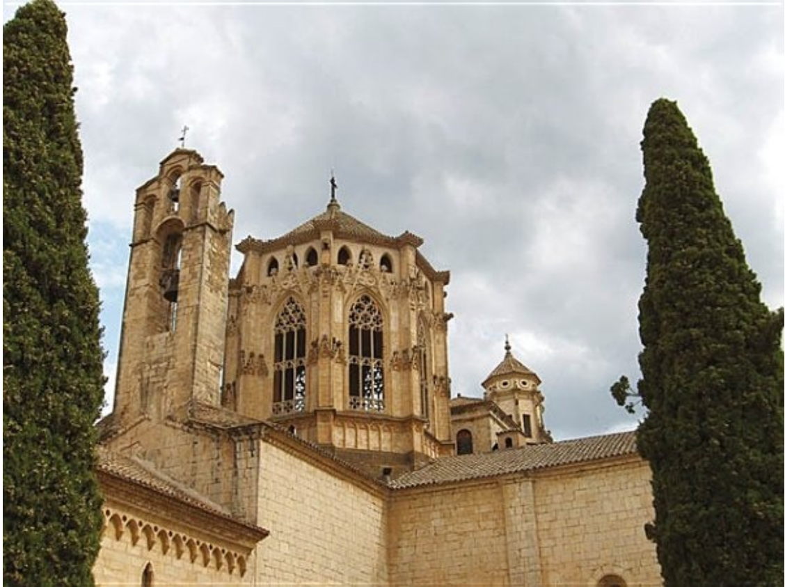
Cimborrio octogonal sobre el crucero de la iglesia del monasterio de Santa María de Poblet, en el que lucen, después de la restauración, sus esbeltos ventanales de fina tracería ojival.
